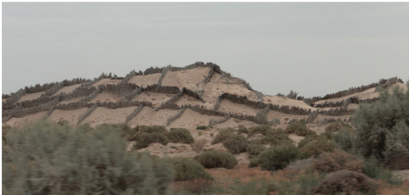
Slika 4. Zaštita od erozijskog premještanja pijeska u sjevernoj Sahari (izvor: https://kids.kiddle.co/Image:North_Sahara._Anti-sand_shields.jpg )
